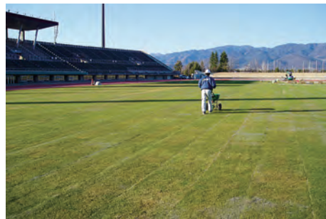
ビッグロール工法施工後の状況
