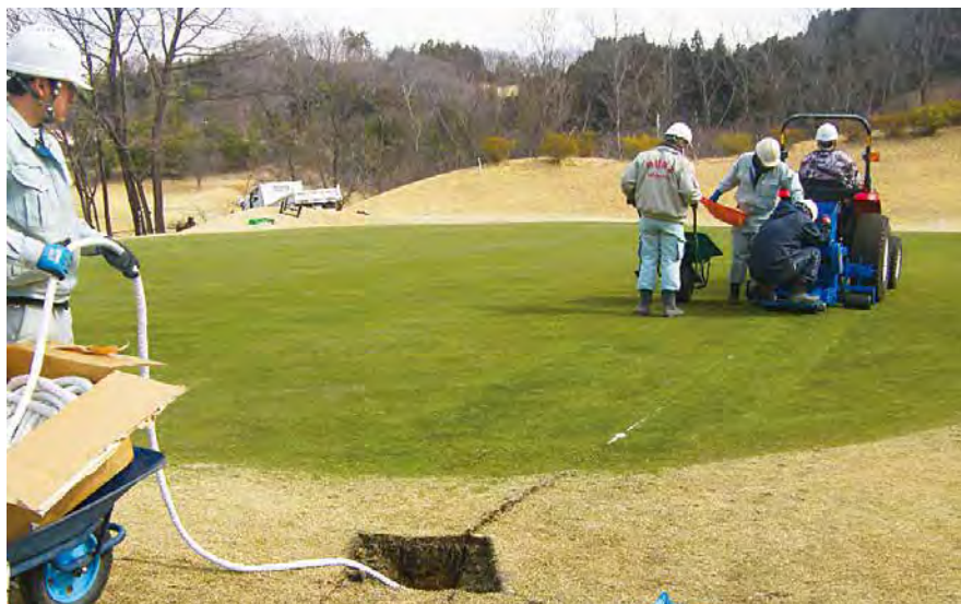
▲サンドカーテンとPCドレーンを同時に敷設します。
